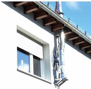
Grundelemente sind zwei Dreiecksbleche, die die Basis schaffen und an der Außenwand angeschraubt werden. Mit dieser Konsolen-Version sind Abstände von 50 bis 100mm möglich.
